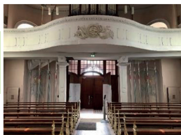
Etayage de la tribune pendant les travaux
