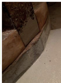
Après: Poutre reposant sur une ceinture béton
