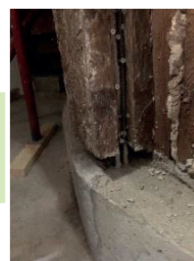
Armatures en fer rapportées dans le bois
