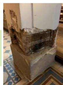
Point de sondage sur pilier
